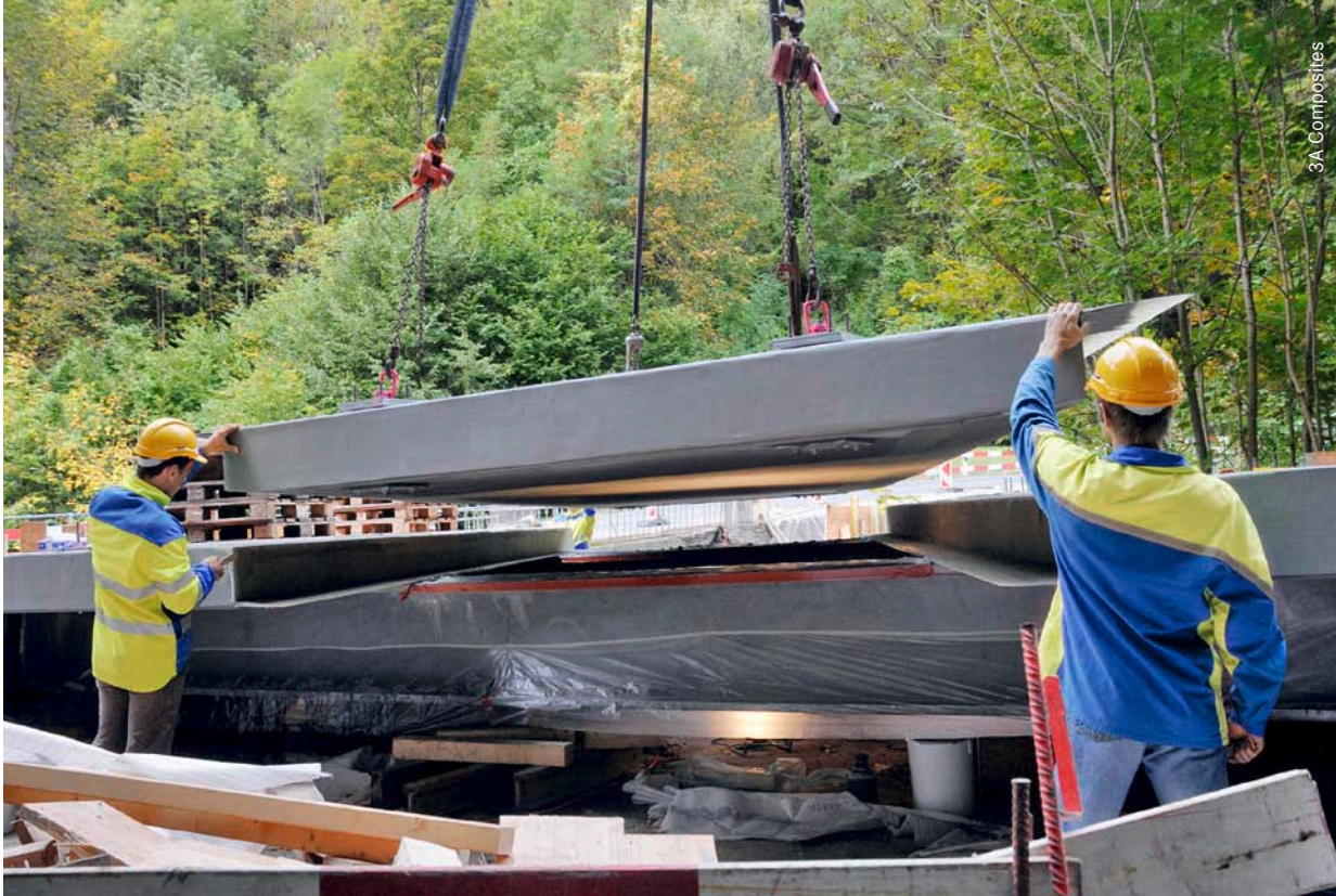
Die neuen Faserverbund-Sandwich-Decks wurden auf der Baustelle verklebt.
