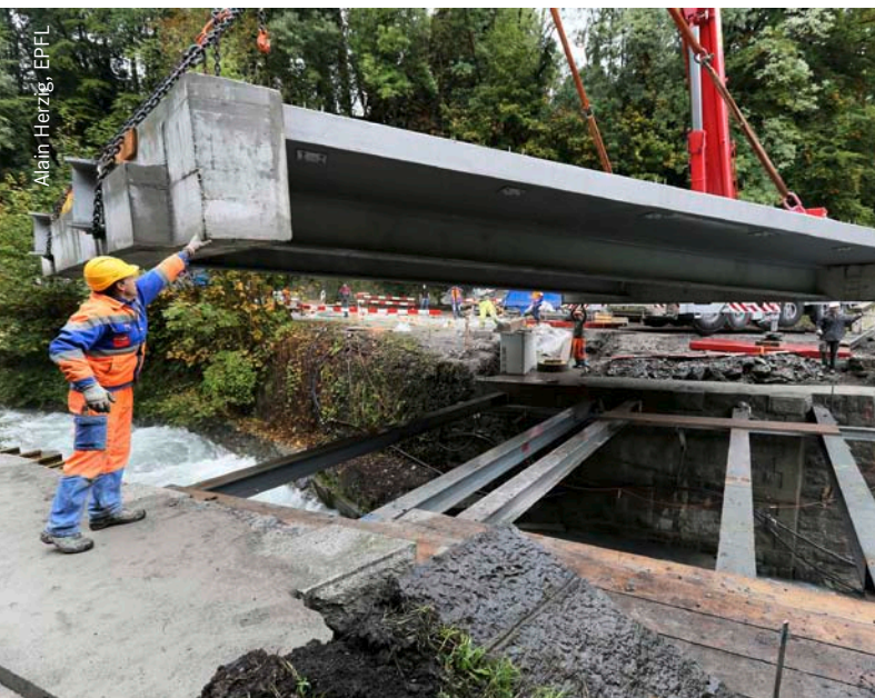
Einheben der fertigen Composite-Brücke.
