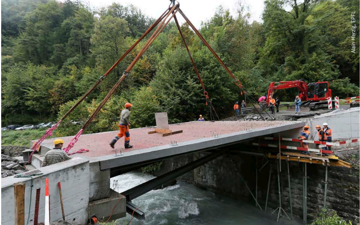
Das frisch installierte Composite-Brückendeck wird noch den Asphalt-Belag und Leitplanken erhalten.
