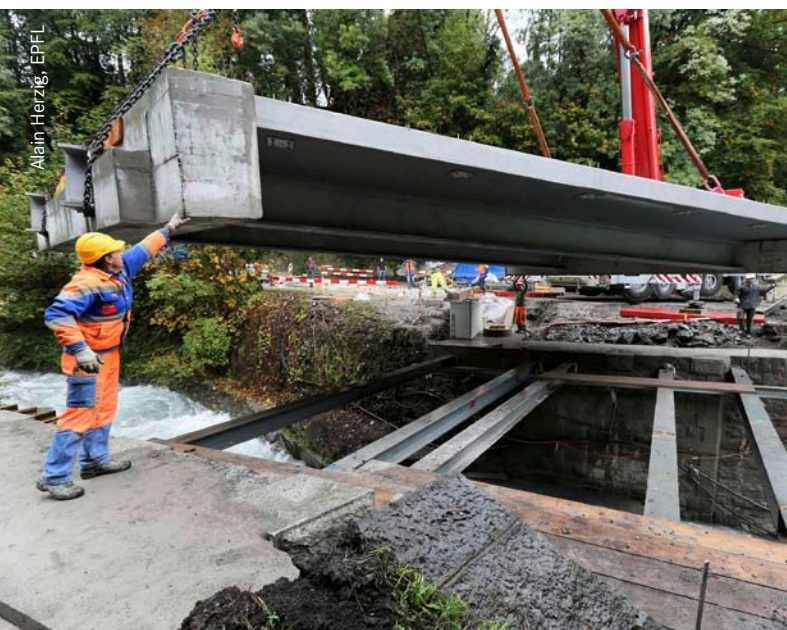
Einheben der fertigen Composite-Brücke.
